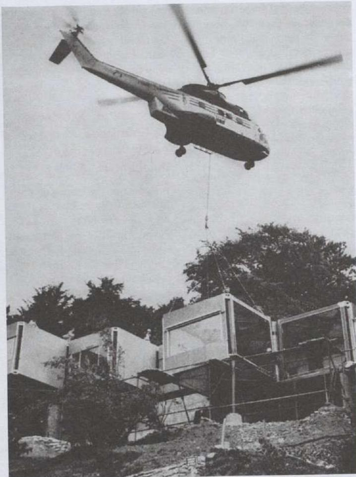
Construction modulaire SIRH (Jean et Claude Prouvé concepteurs). Construction d'un logement prototype à Ludres, transport d'une cellule par hélicoptère. Techniques et architecture, n° 292, avril 1973
