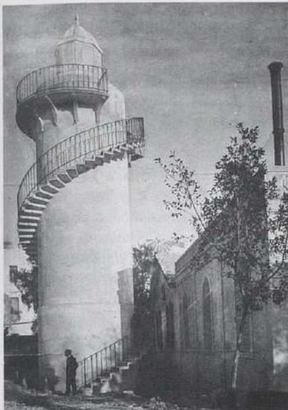
Bétons armés Hennebique. Réservoir d'usine d'épuration d'eau, Tunis, 1910. DR.
