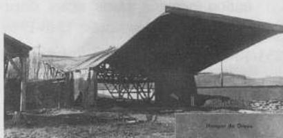
**Prototype d'auvent, Dreux, 1933.** 206 IFA 186/7. LAFBE/S/33/2. Prototype d'essai dont chaque auvent est constitué de deux paraboloides hyperboliques en coque accolés en porte-à-faux de 12,50 m. Structure destinée à la réalisation de hangars à auvent dont la typologie a été mise au point par l'ingénieur Albert Caquot, dir. technique du ministère de l'Air.
