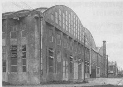
Hangars d'aviation, Metz-Frescaty, 1928-1930 : murs plissés monolithes, couverture en sheds de béton armé. 206 IFA 183. LAFBE/J/28.
