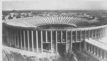
**Rotonde SNCF, Avignon, 1944-1946.** 206 IFA 184/2. LAFBE/M/44/2. Les « V Laffaille » au sol avant levage, vue du chantier (les « V » en attente au sol, puis levés à mesure de l'avancement du coffrage de la voûte), l'ouvrage terminé, [1945-1946].
