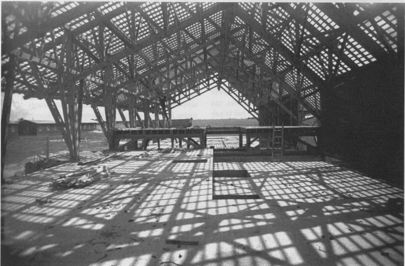
Ferme Quesnel au Bosquel, 1945-1947 : la charpente du bâtiment d'exploitation en construction. 192 IFA 203/5.
