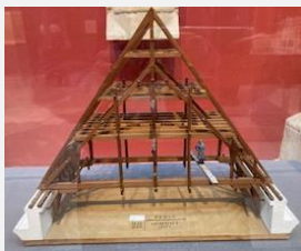
Huit chevrons de la charpente de la nef, vers 1230-1240, Maquette réalisée par Henri Deneux, 1910-1917, Bois, échelle 2 cm/m, Dépôt de la Médiathèque du patrimoine et de la photographie / Centre de recherche sur les monuments historiques
