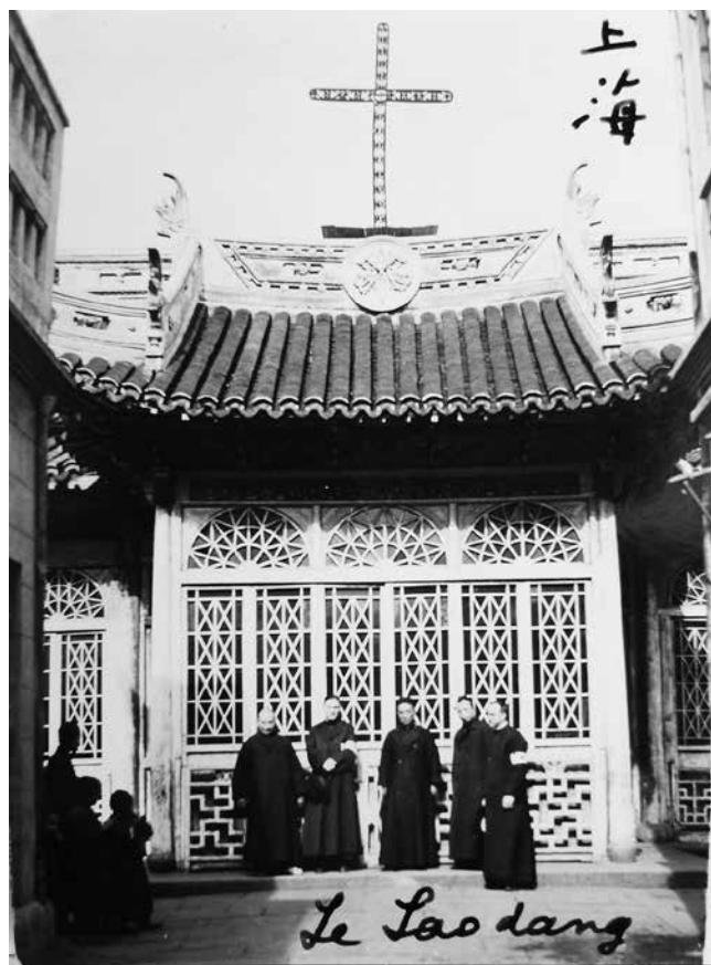
Fig. 2 - Le Lao tang , bâtiment chinois transformé en église par les jésuites vers 1640 (Archives S. J. France, Vanves).
