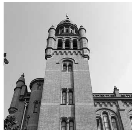
Fig. 47 - Face sud de la tour (THOC, septembre 2016).
