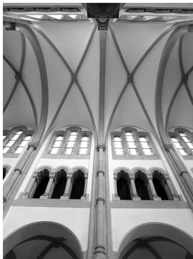
Fig. 35 - Arcade, triforium, clair-étage et voûtes d'ogives de la nef (THOC, septembre 2016).
