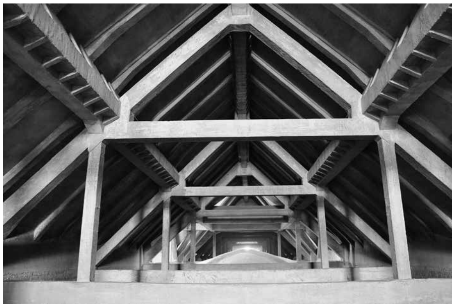
Fig. 38 - Charpente de la nef en béton armé (THOC, mai 2011).
