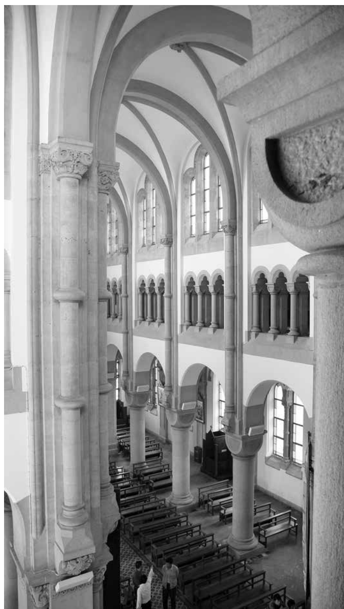
Fig. 35 - Arcade, triforium, clair-étage et voûtes d'ogives de la nef (THOC, septembre 2016).
