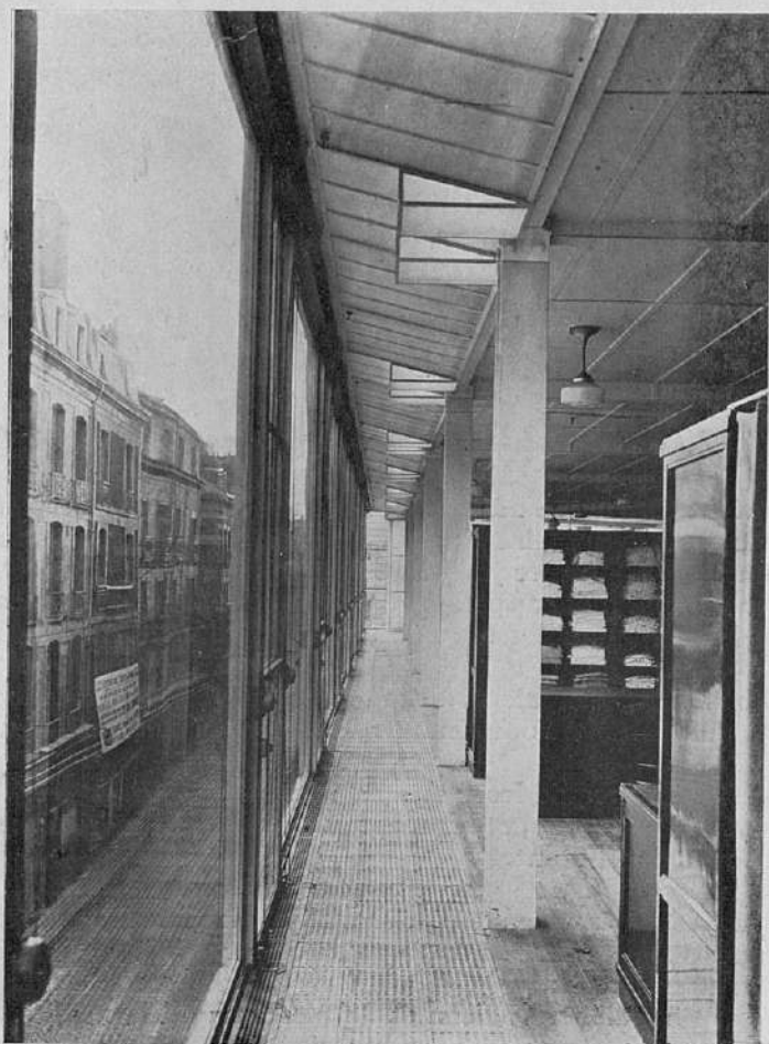
VUE INTÉRIEURE D'UN ÉTAGE MONTRANT LA FAÇADE EN PORTE-A-FAUX
