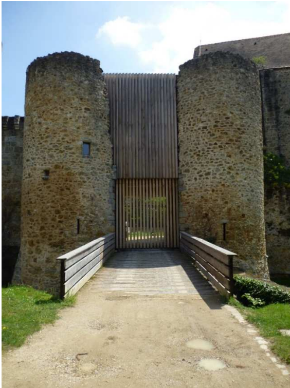
Château de Chevreuse - Aménagement de bureaux dans la poterne. Source photo personnelle Marie-Laure Petit.
