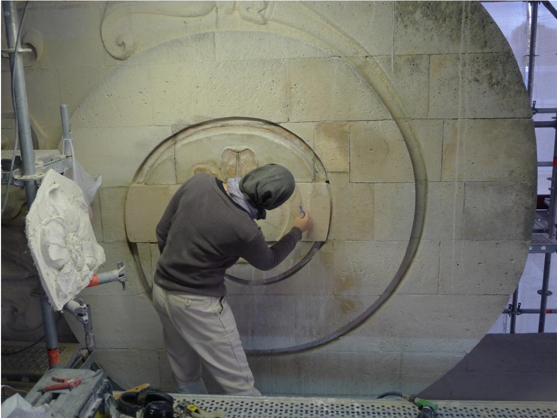
Restauration de la façade de l'église du Val-de-Grâce - Paris, 2016 © Stefan Manciulescu, ACMH
