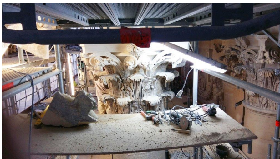
Restauration de la façade de l'église du Val-de-Grâce - Paris, 2016 © Véronique Cordier
