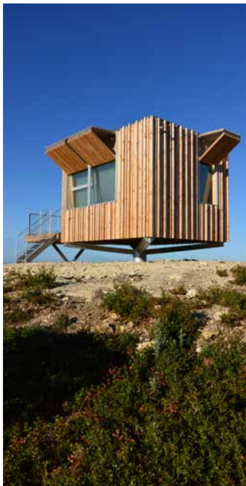
Construction d'une vigie d'un poste de surveillance à Saint-Mitre-les-Remparts (13) par OH!SOM architectes, © OH!SOM architectes
