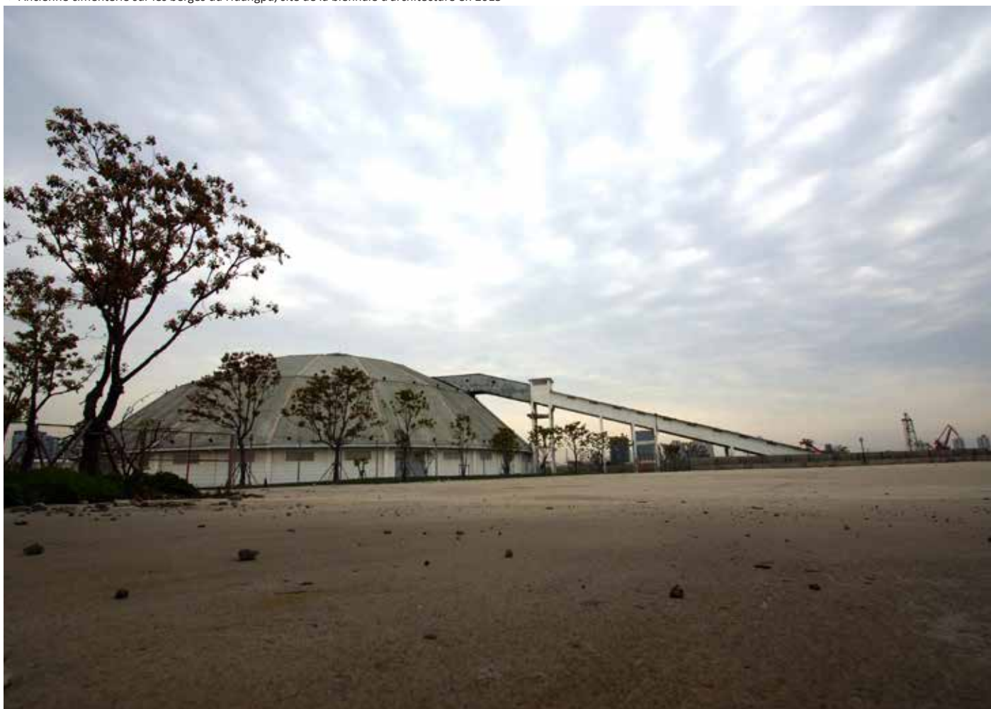
> Ancienne cimenterie sur les berges du Huangpu, site de la biennale d'architecture en 2013
