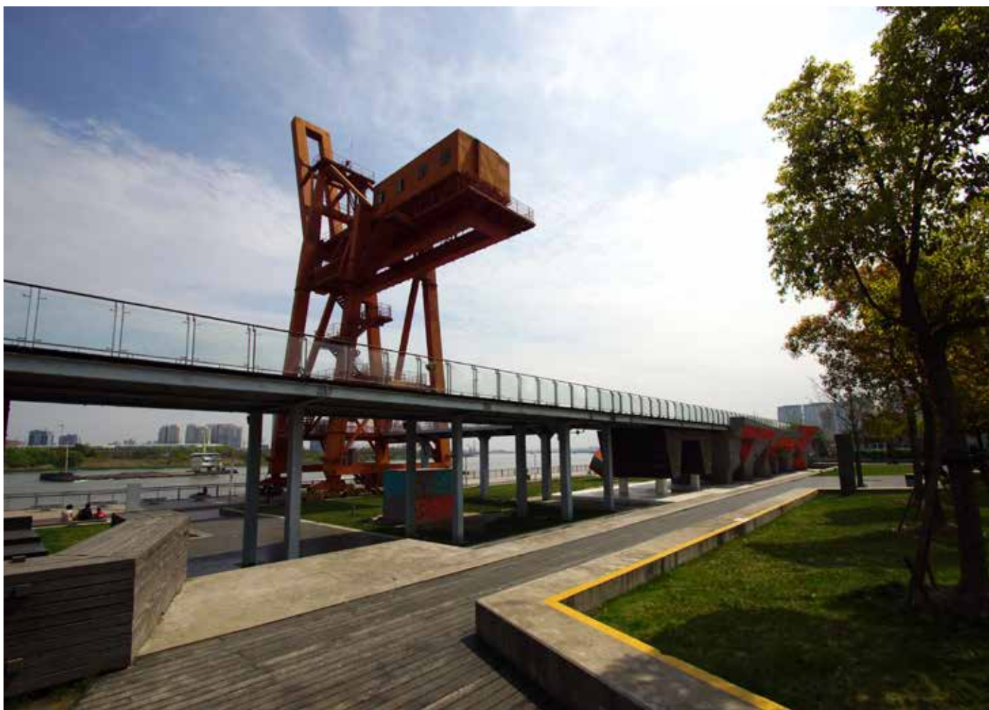
> Passerelles, grue et mur d'escalade, le long des berges du Huangpu
