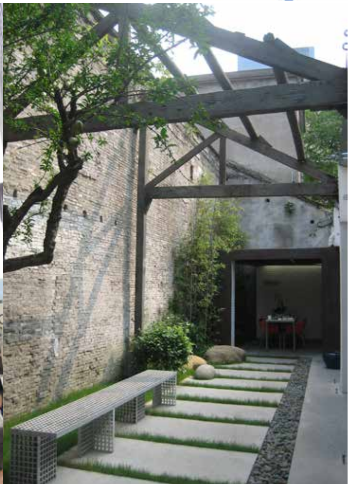
> Petite cour créée en ouvrant une travée
