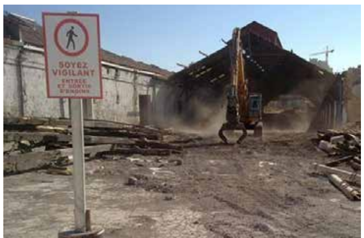
> Démolition avant la dépollution.
