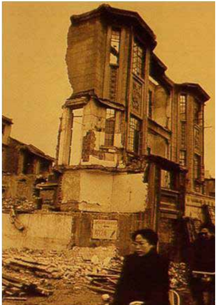
2 > Démolition à Shanghai dans les années 1990-2000
