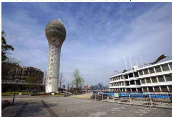
> Ancienne tour de contrôle conservée de l'aéroport disparu de Longhua
