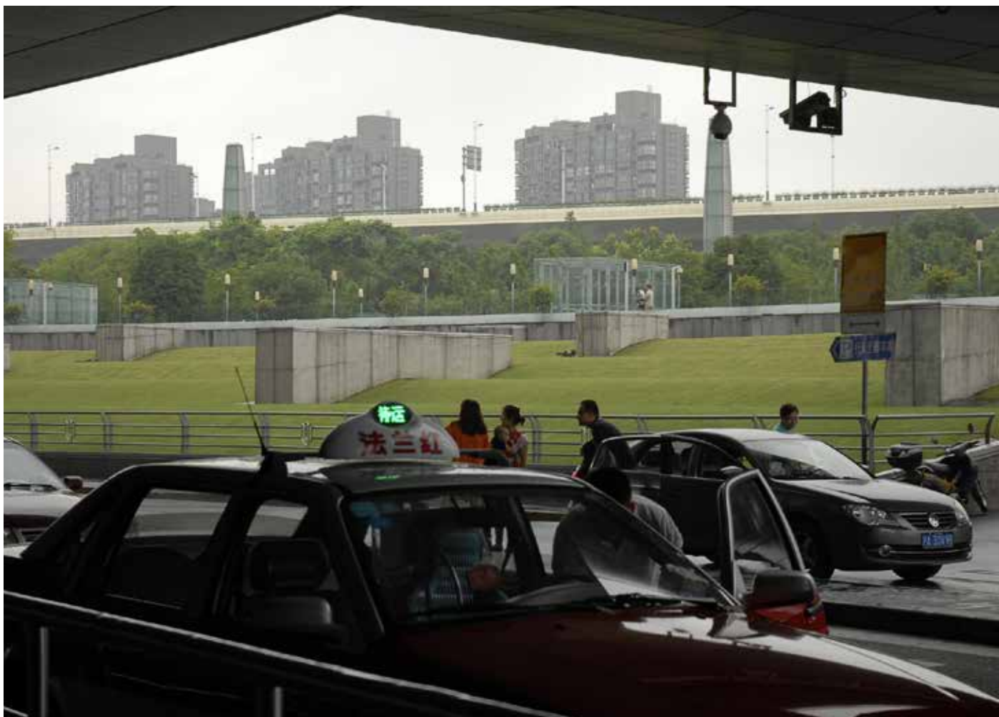
> Accès taxi dans les soubassements de la gare
