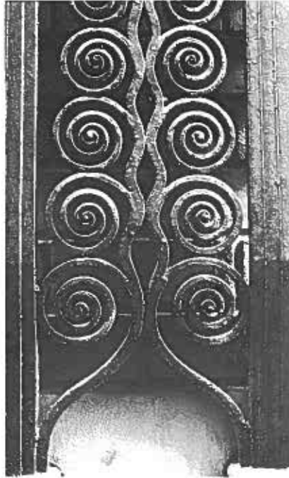
François Le Cœur, Central téléphonique Bergère, Paris : détail de ferronnerie. Cl. Étienne Revault, 1994.
