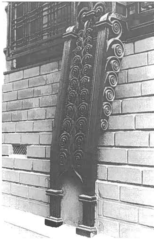
Central téléphonique Bergère, Paris : détail de ferronnerie. Cl. Étienne Revault, 1994.
