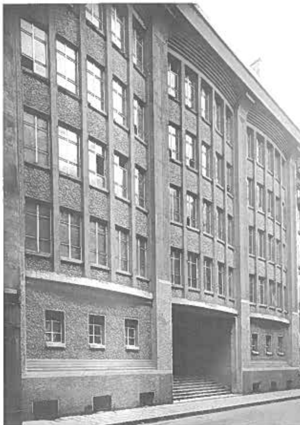
Central téléphonique rue du Temple, Paris : a façade vers 1925.
