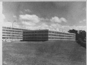
1959-1964. Ensemble de logements, Biarritz
