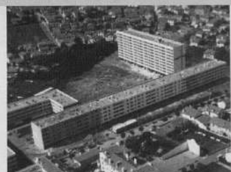
1959-1964. Ensemble de logements, Biarritz
