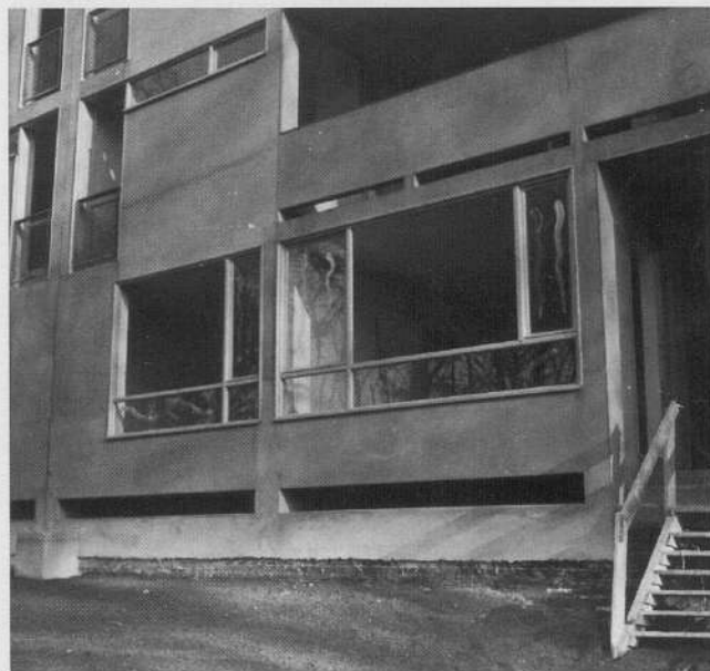
Résidence du Parc, 1952-1954 : pose des huisseries, détail.
