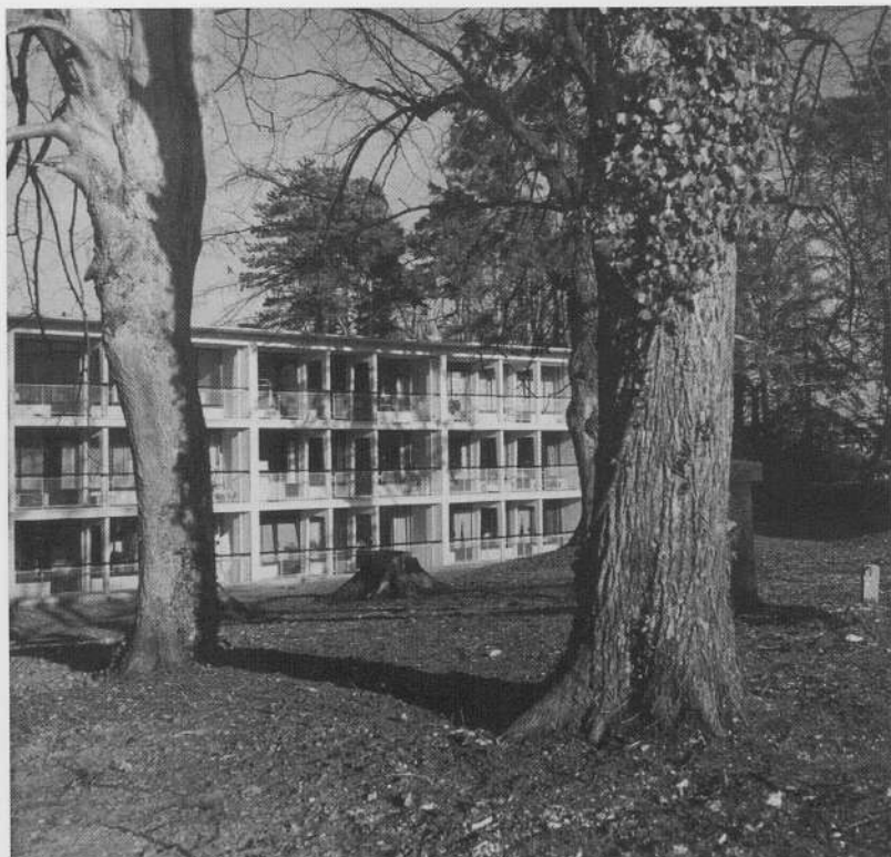
SHAPE Village, 1951-1952, loggias avec portiques préfabriqués.
