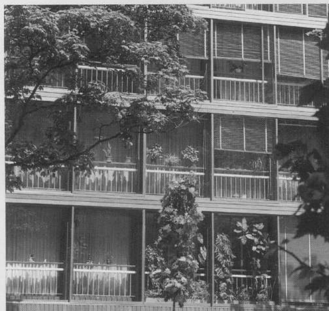
63, av. de la Bourdonnais, 1958-1962 : la double façade (cl. L. Pinsard). Le plan s'enroule autour de la distribution verticale, tandis que la façade n'est plus seulement la limite du plan mais une surface « capable », objet de tous les possibles.
