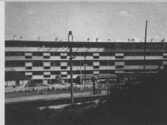
1953. Reconstruction de l'îlot de la gare, Saint-Lô
