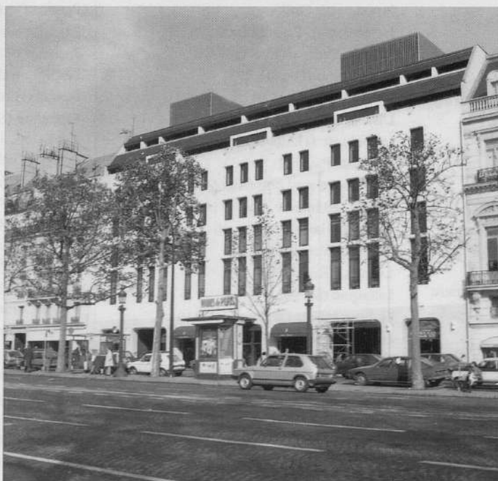
Immeuble de bureaux, 26, av. des Champs Élysées, Paris, 1976-1983 (n° 141).
