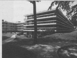
1969-1973. Immeuble Pershing, Versailles
