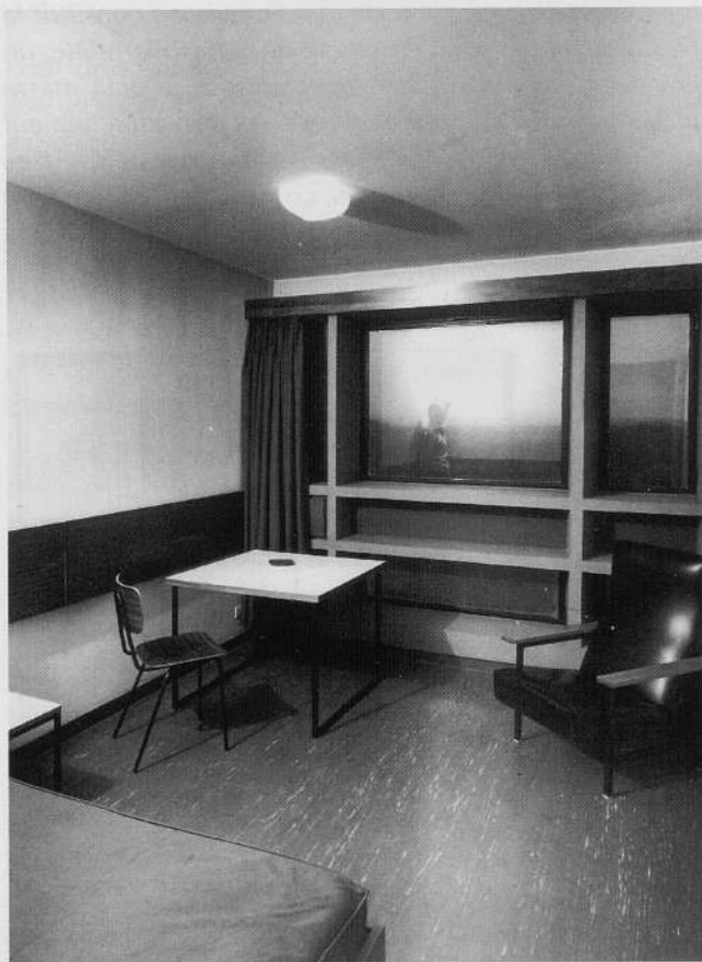
Résidence Cormontaigne, 1959-1962 : l'intérieur d'une chambre (cl. G. Martin). La cellule, même si elle est spartiate, permet au moins de positionner le lit dans les deux sens. Dans l'épaisseur du panneau préfabriqué se logent une petite bibliothèque et un coffre. Le rapport qualité-coût intéressera bon nombre d'hôteliers.
