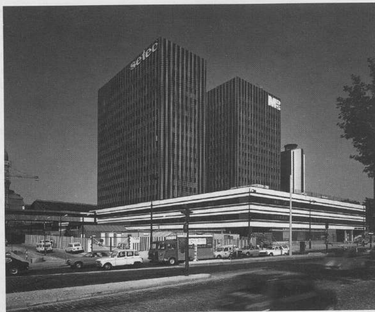
Immeubles de bureaux Bercy-La Rapée, Paris, 1959-1978 (nos 57 et 70).
